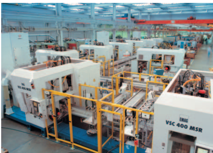
Los centros de Producción multi-funcionales están integrados frecuentemente en líneas de producción destinadas al mecanizado completo de ciertas piezas. En esta foto, una línea de producción de 8 máquinas concatenadas para el mecanizado completo de discos de freno.
